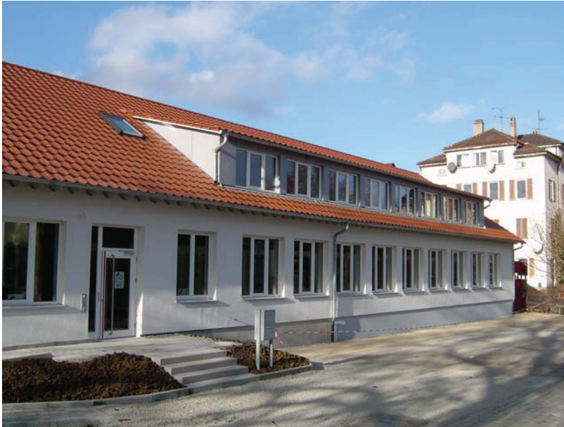
Abb 1: Fassade und Eingangsbereich
