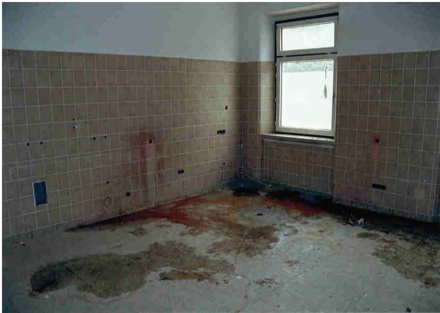
Bild 1: Ehemalige Zahnarztpraxis vor der Sanierung
