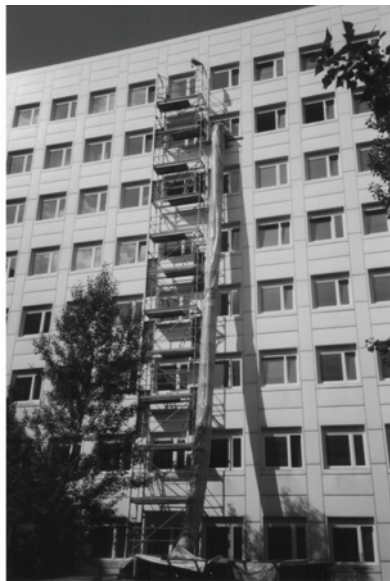
Foto 1: Haus A während der Sanierung
