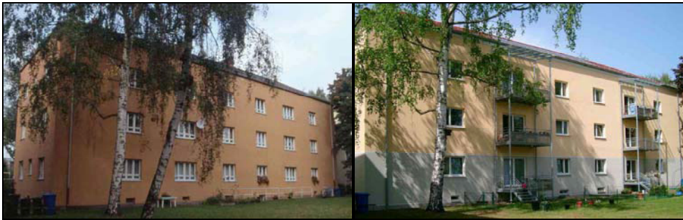
Abb. 11 Drei-Liter-Haus (WBG Nürnberg) am Jean-Paul-Platz 4 in Nürnberg vor und nach der Sanierung
